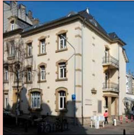
Das Hauptgebäude der Caritas in der Rue Michel Welter
